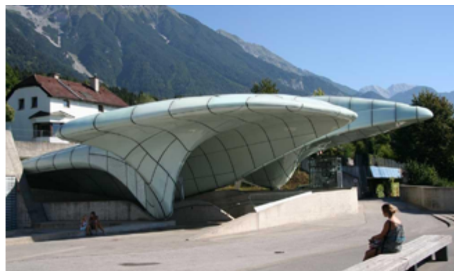
Eine Herausforderung für Bauleute: Die anspruchsvolle Bauweise der Bergstation der Hungerburgbahn von Zaha Hadid
